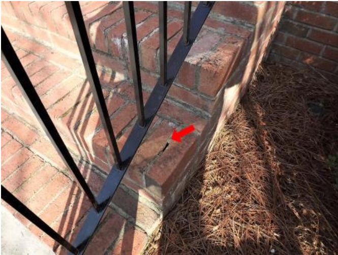
Missing mortar.
