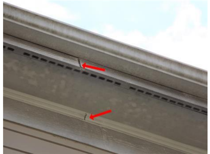
Separation in flashing/trim.
